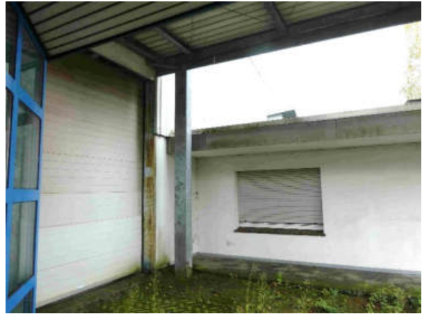
Foto 28: nördlicher (Zugangs-)Bereich mit Anbau
