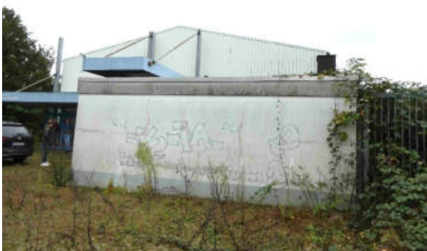
Foto 31: Anbau mit Blick von Norden
