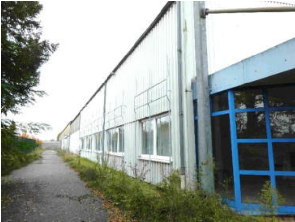
Foto 27: östliche Seite der Halle; hier im Norden mit Trapezblechen verkleidet
