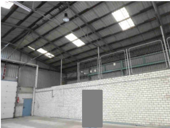
Foto 35: Halle (nördlicher Bereich)
