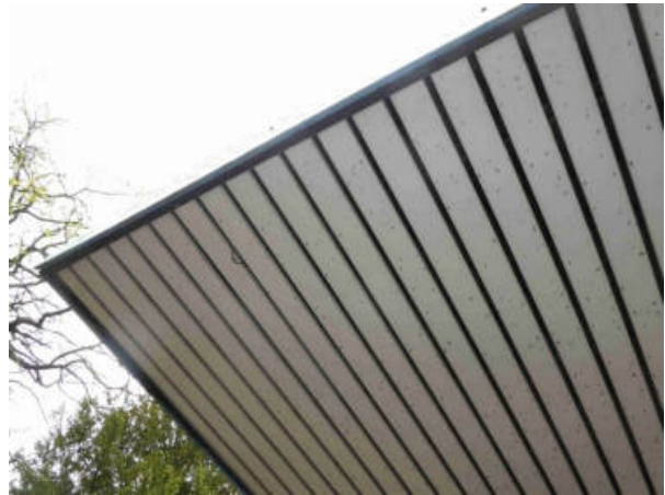
Foto 30: Überdachung intakt (schwarz Streifen = keine Spalten)
