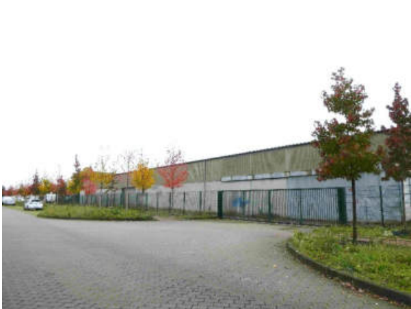
Foto 5: Zufahrt (Anlieferung) im Osten aufs Dohr-Gelände und ...
