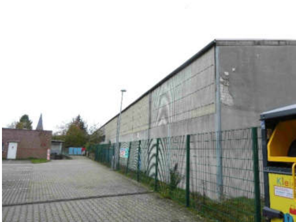
Foto 1: Dohr-Gelände im Südwesten mit fast grenzständiger Halle des Dohr-Geländes neben einem Lebensmittelmarkt
