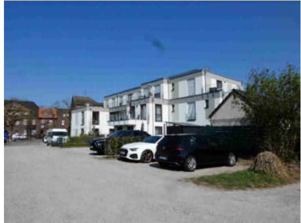
Foto 22: Westseite etwas südlicher: Parkplatz geschottert
