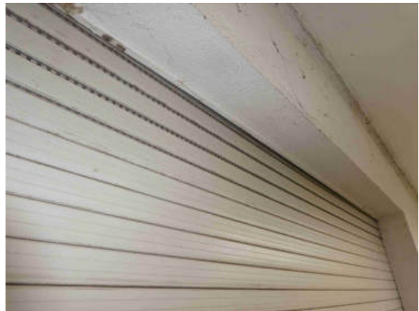
Foto 32: sehr schmaler Spalt in den innenliegenden Rollladenkasten
