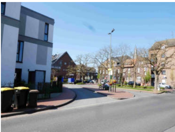
Foto 19: Platzsituation nördlich des PG mit Bushaltestelle
