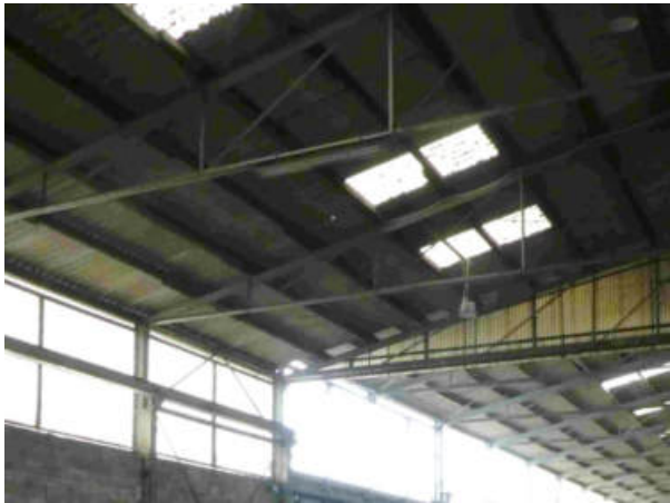
Foto 45: Höhenversprung innerhalb der Halle
