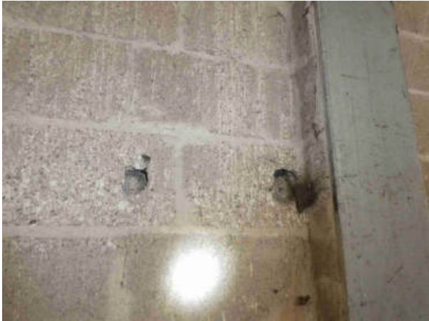
Foto 39: beschädigte Hohlziegel ...
